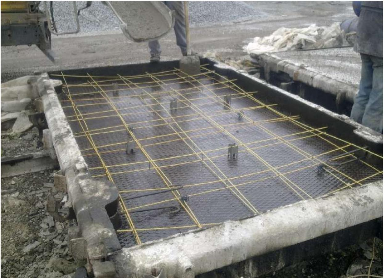
Фото 19. Изготовление дорожной плиты
