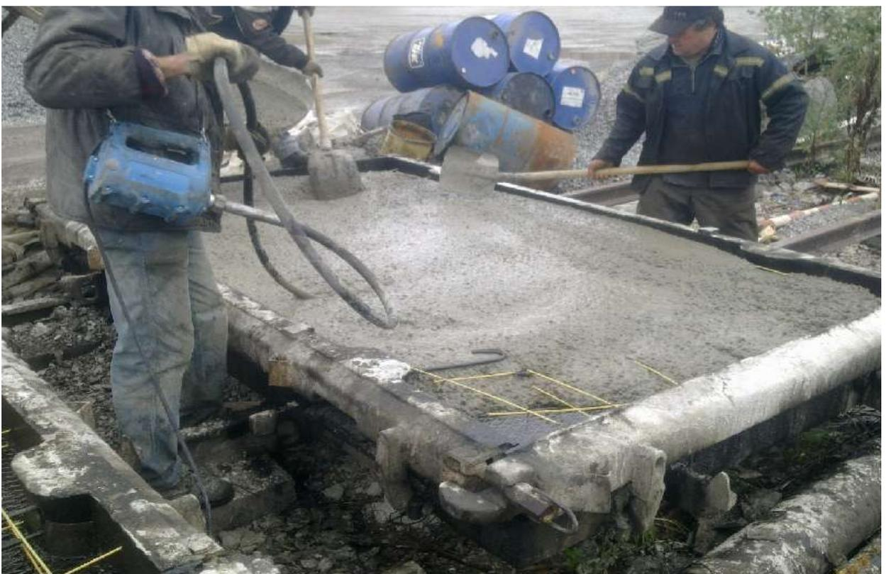
Фото 20. Изготовление дорожной плиты
