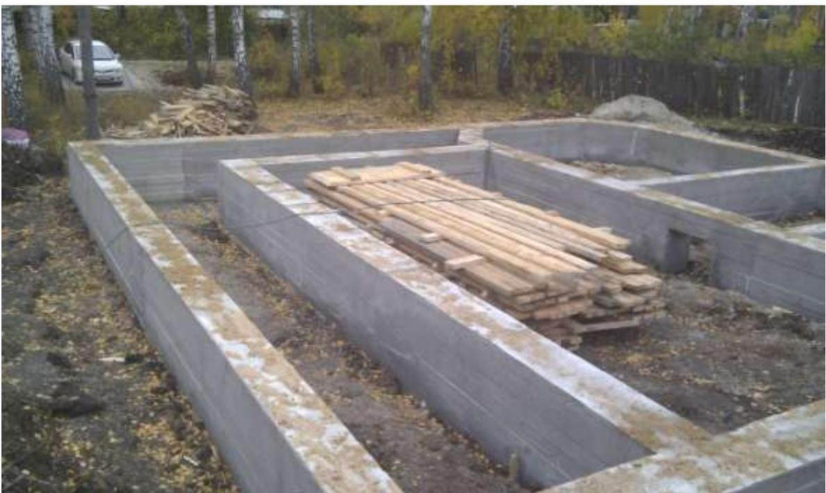
Фото 4. Готовый фундамент после заливки бетона.
