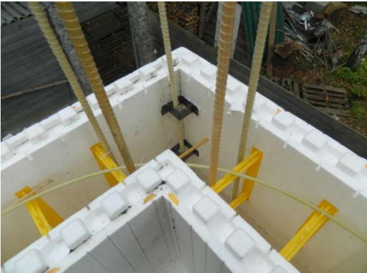
Фото 10. Двух этажный коттедж в Ильинском районе Пермского края (армирование стены из не съемной опалубки).
